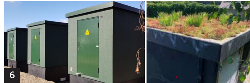
Referentiebeeld van groene transformatoren met sedumdak.
