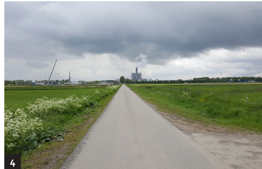
4 Zicht vanaf de Nieuwgraafsestraat richting bedrijventerrein Innofase.
